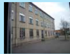
Façade SO Primaire
