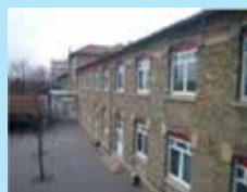
Façade SE Primaire
